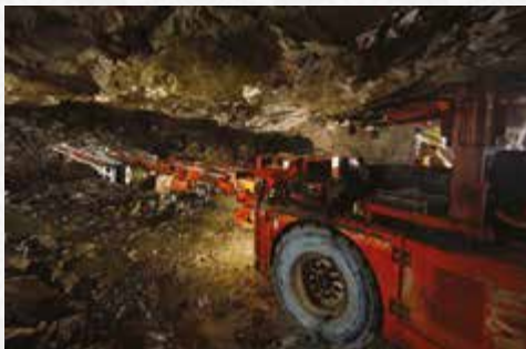
Drill rig – DD211L
